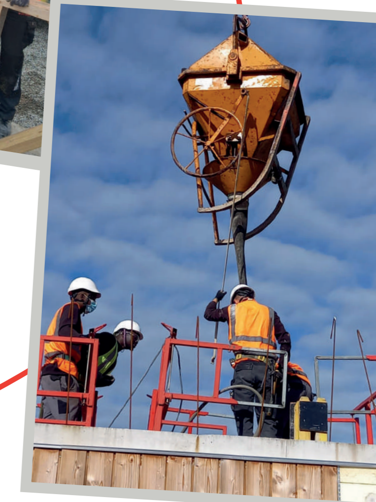
Formation Coffreur Bancheur 2025 Siti Intérim Vannes
