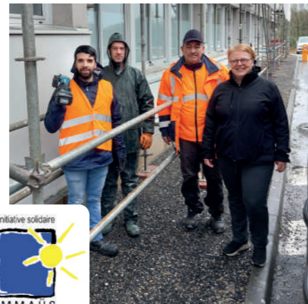
Laëtitia THEBAUD accompagnée de Laurent, encadrant technique et de Kévin et Sefatullah, intérimaires en parcours, mobilisés sur un chantier réemploi à Vannes.
